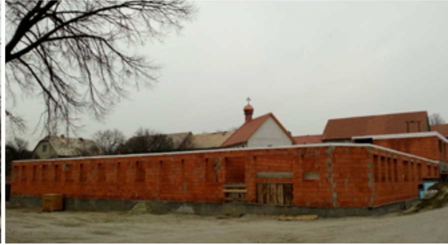
Kaplnka svätého Jozefa a nový areál Domu svätého Juraja vo výstavbe.
